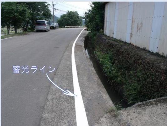
側溝脇に蓄光塗料を塗布(昼間)イメージ
